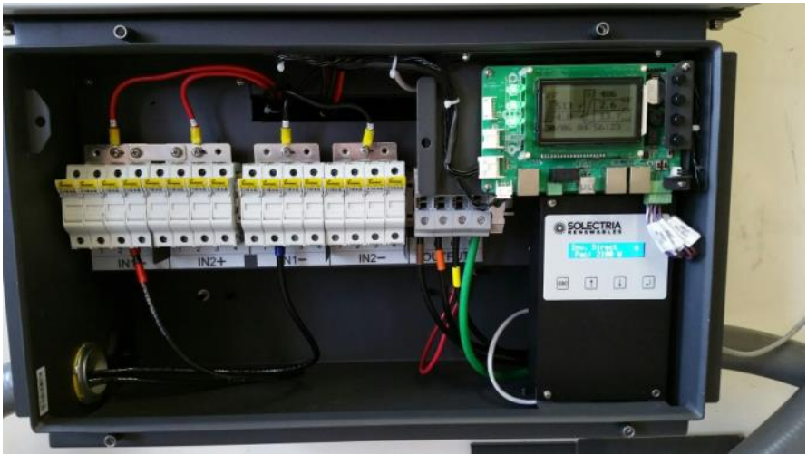
Figura 8.3 - Monitoreo SolrenView instalado dentro de la caja de cableado
