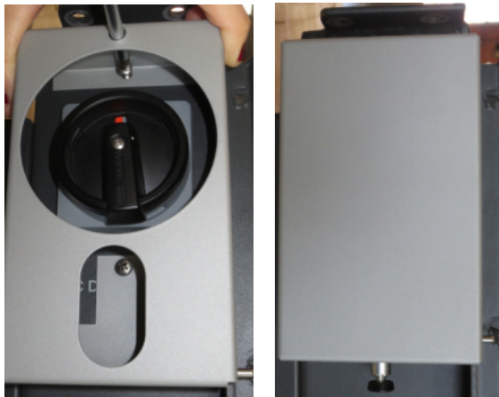
Figura 8.5 - Cubierta a prueba de alteraciones
