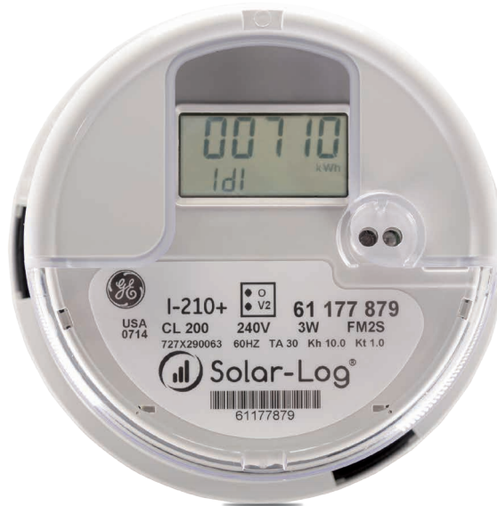
Solar-Log 350 & GE Meter
