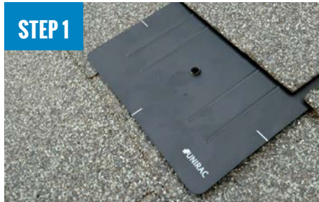
INSTALL FLASHKIT PRO FLASHING
