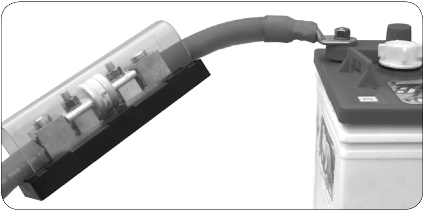
Fig. 3,20. Connexion du câble positif à la batterie, avec assemblage de fusible classe "T"
